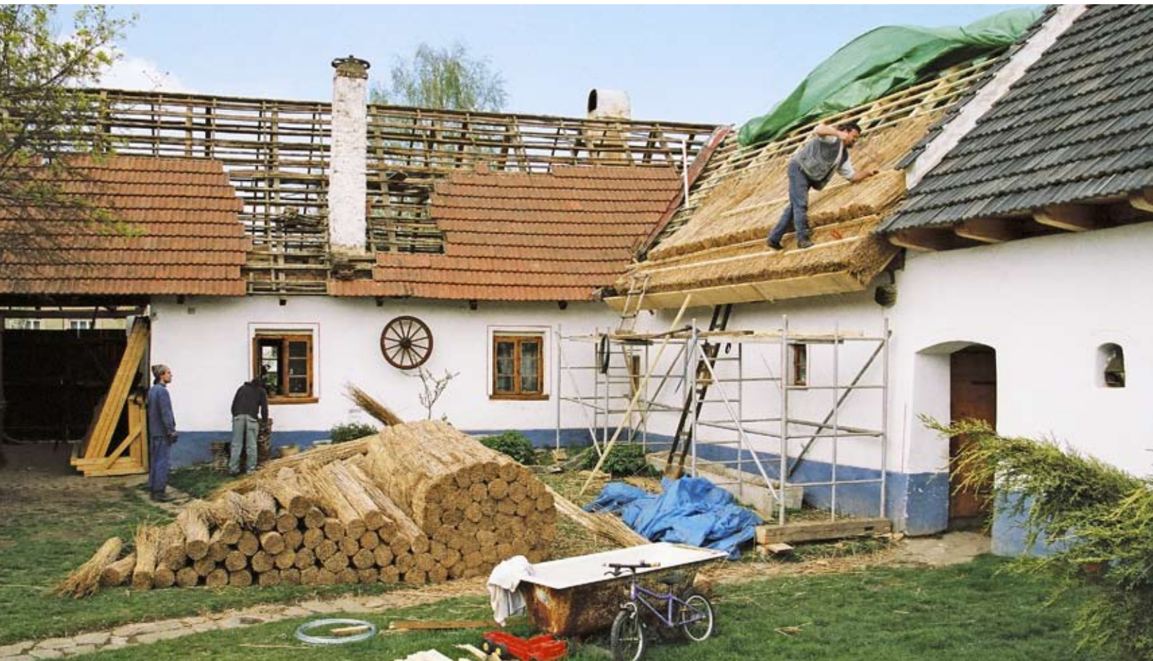
Takto vypadá pošívání střechy rákosovými doškami v praxi – dole je připravený materiál
