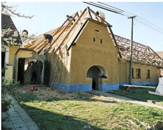
Osazování krokví; tesaře pak vystřídají neobvyklí pokrývači
