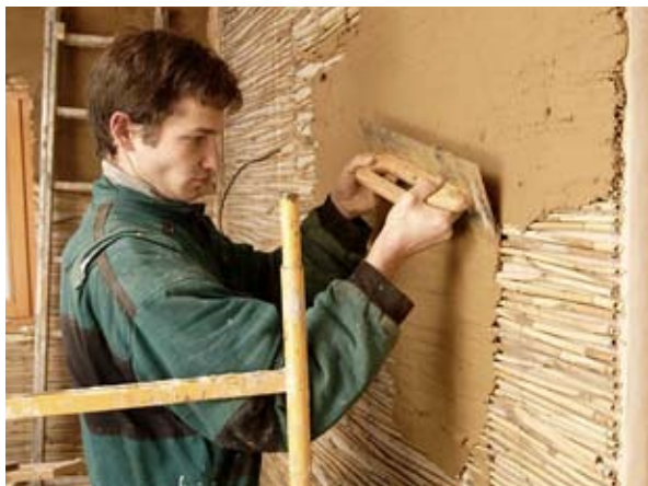
Rákosové panely lze použít pro kontaktní fasádní systém místo polystyrenu, nebo uvnitř domu jako nosiče hliněných omítek (HLINENYDUM.CZ)
