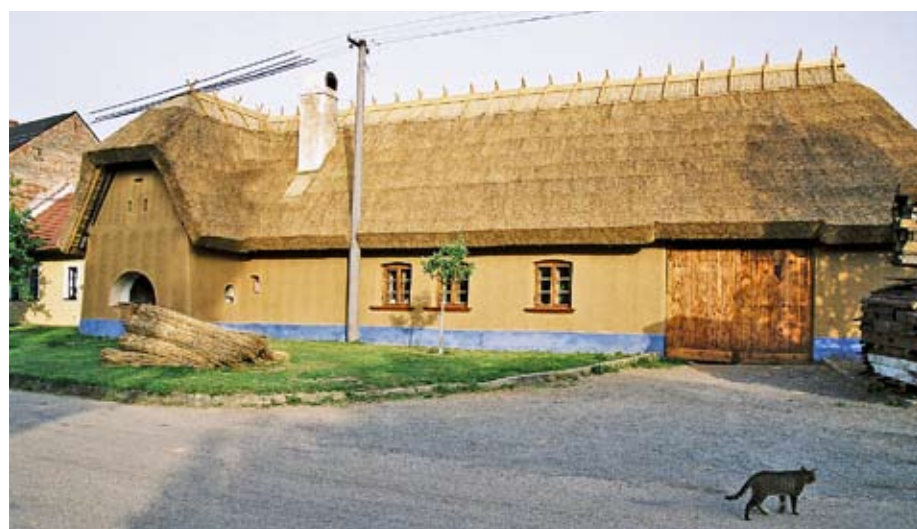
Kompletně dokončená rákosová došková střecha na rekonstruované vesnické historické stavbě v Lisovicích, okres Vyškov – před domem vidíte nezpracovaný materiál ( www.hlinenydum.cz )
